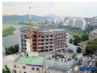
<태화루 복원 예정지 철거 현장>
