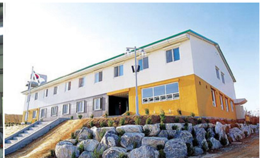
그림 5-27 파주지역 내무생활관 개선공사
