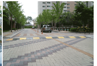
[서행유도 시설물 설치]
