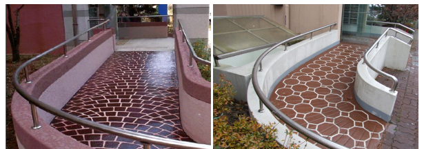
[노후한 경사로의 바닥 보수]
